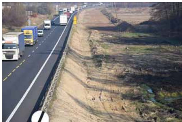
_WIDOK PLACU BUDOWY WSCHODNIEJ JEZDNI S3 SULECHÓW - ZIELONA GÓRA
