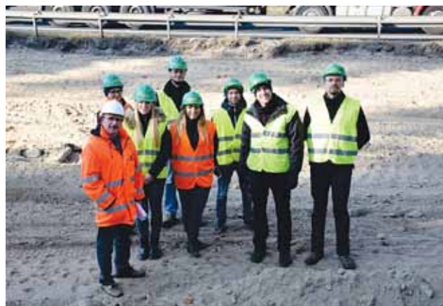
_GRUPOWE ZDJĘCIE UCZESTNIKÓW WYCIEZKI NA PLACU BUDOWY S3
