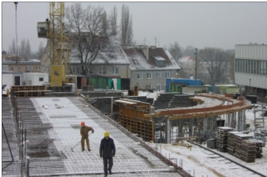
NA PLACU BUDOWY INSTYTUTU BUDOWNICTWA
