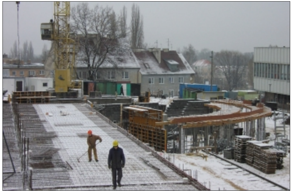
NA PLACU BUDOWY INSTYTUTU BUDOWNICTWA
