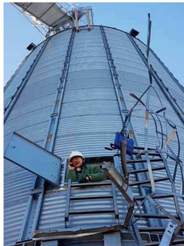
PODZAS EKSPERTYZY, W STALOWYM SILOSIE NA ZBOŻE W 2018 R. FOT. ARCHIWUM PRYWATNE
