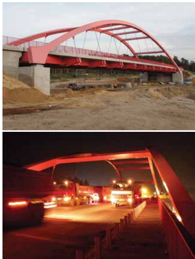
WIDOK WADUKTU PRZED BADAANIEM POD PRÓBNYM OBCIĄŻENIEM
