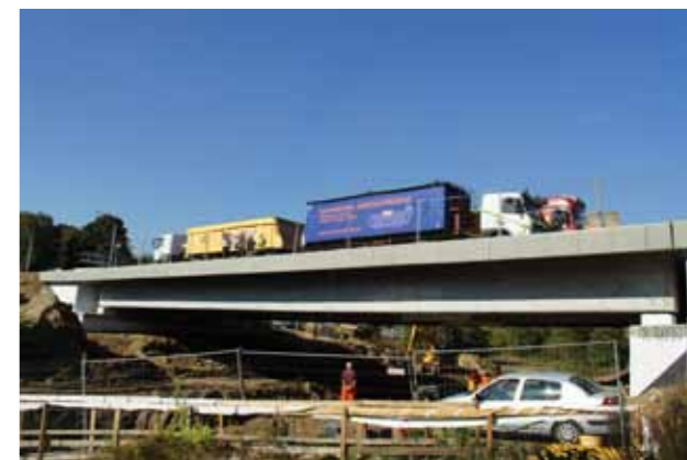
WIDOK BADAJEGO WIADUKTU POD PRÓBNYM OBCIĄŻENIEM
