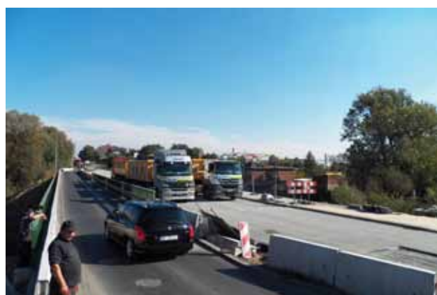
WIDOK SAMOCHODÓW CIĘŻAROWYCH NA OBIEKcie PODCZAS PRÓBNEGO OBCIĄŻENIA ORAZ WYKORZYSTANIA KŁADKI DO RUCHU WAHADŁOWEGO
