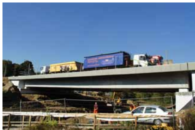
WIDOK BADAŃ WIAADUKTU POD PRÓBNYM OBCIĄŻENIEM
