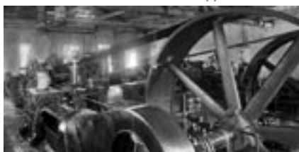
RYŚ. 2. GENERATOR NAPEĐZANY PASEM TRANSMISYJNYM.[11]
