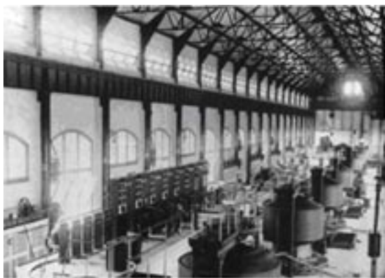
RYS. 5 WNĘTRZE ELEKTROWNI WODOSPAD NIAGARA[13].
