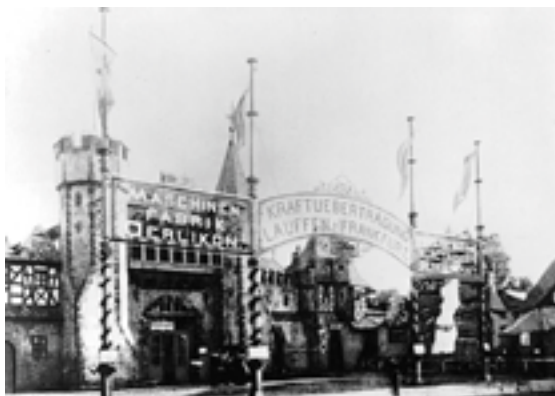
RYS. 6. STACJA KOŃCOWA LINII ZBUDOWANEJ PRZEZ MICHAŁA DOLIWO-DOBROWOLSKIEGO[8].
