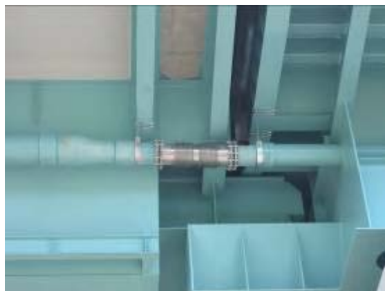
RYŚ. 15. WIDOK NOWOCZESNEGO ODWODNIENIA MOSTU (BĘDĄCEGO W BUDOWIE) Z ZASTOSOWANIEM KOMPENSACJI ZE STALI SZŁACHETNEJ.
