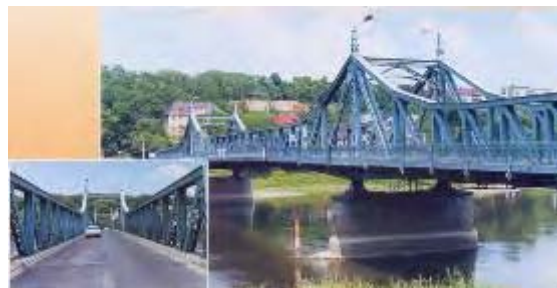
RYŚ. 18. PRAWIDŁOWO UTRZYMANY DROGOWY MOST KRATOWY W KROŚNIE ODRZAŃSKIM Z UŻYCIEM NOWOCZESNYCH MATERIAŁÓW I TECHNOLOGII. (MOST STALOWY KRATOWY TRÓJPRZESŁOWY DŁUGOŚCI 164 M).
