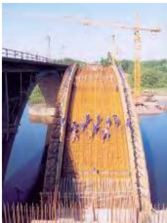
RYS. 19. BUDOWA BLIŹNIACZEGO MOSTU GRANICZNEGO W ŚWIECKU.
