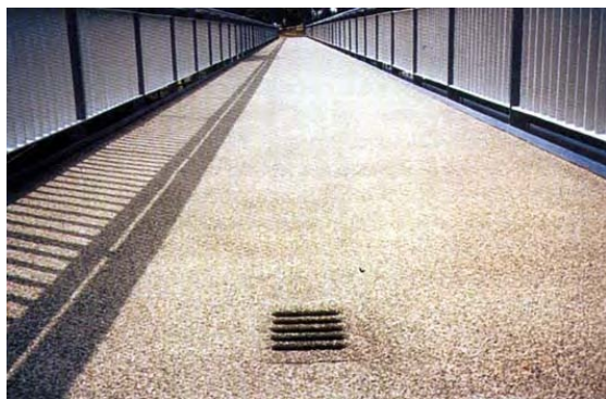
RYŚ. 14. NOWOCZESNA CIENKA NAWIERZCHNIA EPOKSYDOWA NA KŁADCE DLA PIESZYCH.
