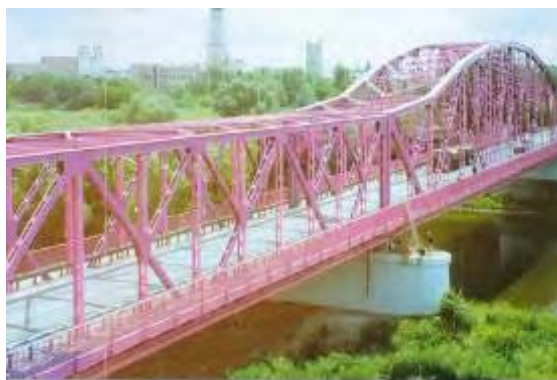
RYŚ. 16. RENOWACJA STALOWEGO MOSTU KRATOWEGO Z UŻYCIEM MATERIAŁÓW MALARSKICH O WYSOKIEJ TRWAŁOŚCI (OD 30 DO 40 LAT). WYBÓR KOLORYSTYKI ZALEŻY OD ZARZĄDZAJĄCEGO....
