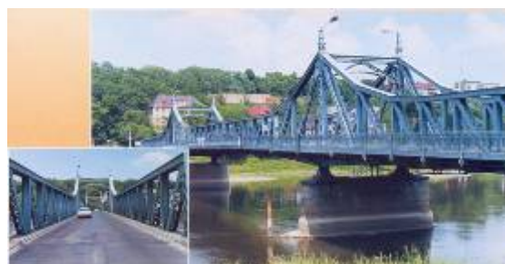
RYS. 18. PRAWIDŁOWO UTRZYMANY DROGOWY MOST KRATOWY W KROŚNIE ODRZAŃSKIM Z UŻYCIEM NOWOCZESNYCH MATERIAŁÓW I TECHNOLOGII. (MOST STALOWY KRATOWY TRÓJPRZEŚŁOWY DŁUGOŚCI 164 M).
