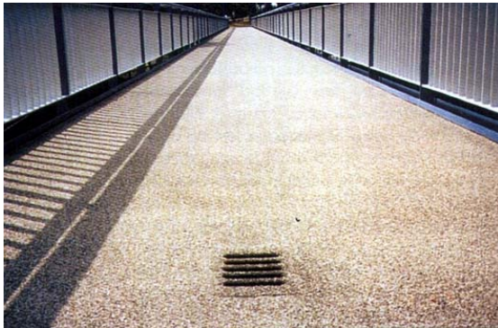
RYS. 14. NOWOCZESNA, CIENKA NAWIERZCHNIA EPOKSYDOWA NA KŁADCE DLA PIESZYCH.
