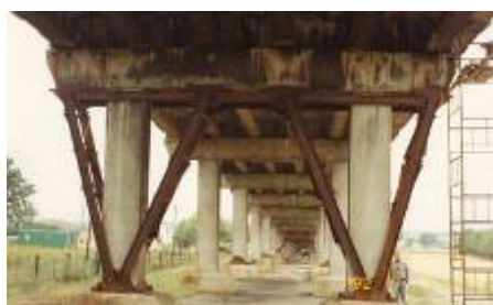
RYS. 12. TYPOWE USZKODZENIA MOSTÓW PREFABRYKOWANYCH WYBUDOWANYCH W LATACH 70 XX W. – WIDOCZNE SĄ SKUTKI NISKIEJ JAKOŚCI WYKONAWSTWA.
