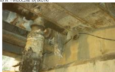
RYS. 13. USZKODZENIA WYWOŁANE ZŁYM UTRZYMANIEM MOSTU MIEJSKIEGO
