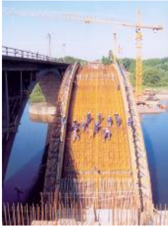
RYS. 19. BUDOWA BLIŹNIACZEGO MOSTU GRANICZNEGO W SWIECKU.
