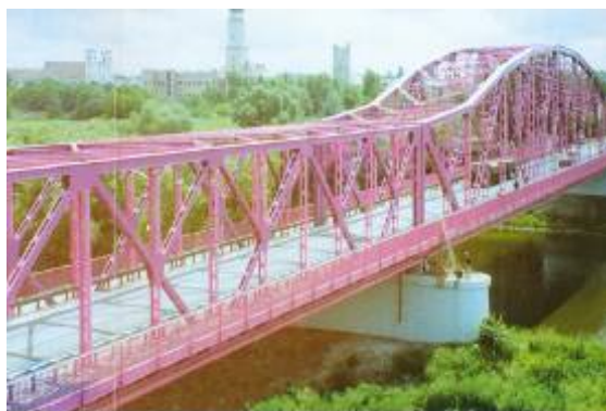
RYS. 16. RENOWACJA STALOWEGO MOSTU KRATOWEGO Z UŻYCIEM MATERIAŁÓW MALARSKICH O WYSOKIEJ TRWAŁOŚCI (OD 30 DO 40 LAT). WYBÓR KOLORYSTYKI ZALEŻY OD ZARZĄDZAJĄCEGO....
