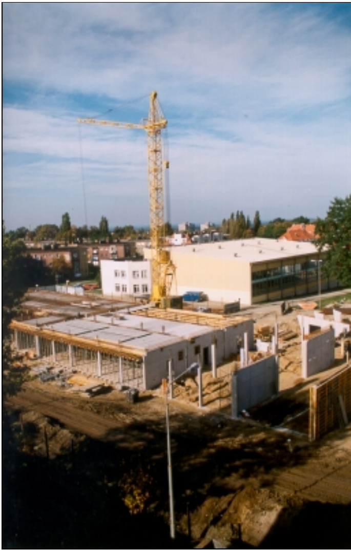
W CAMPUSIE PRZY PODGÓRNEJ TRWAJĄ PRACE MONTAŻOWE W POWSTAJĄCYM OBIEKcie WYDZIAŁU NAUK ŚCISŁYCH
