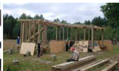
FOT. J. JUCHIMIUK, M. GOLAŃSKI, III ETAP BUDOWY EKSPERYMENTALNEGO HABITATU - BAĆ-ARKA
