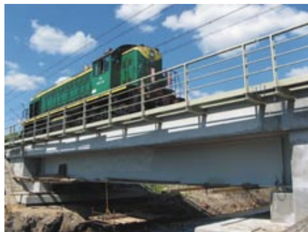
ZDJ. 2. PRZEJAZD LOKOMOTYWY PODCZAS BADANIA DYNAMICZNEGO
