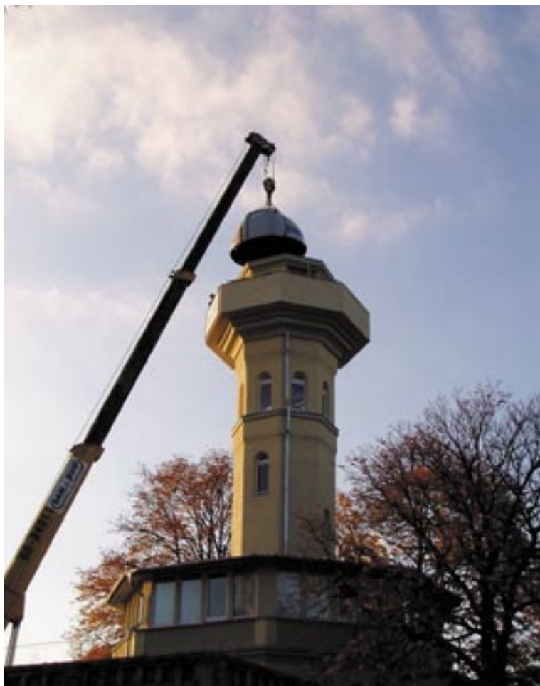
MONTAŻ KOPUŁY NA SZCZYCIE WIEŻY BRANIBORSKIEJ
