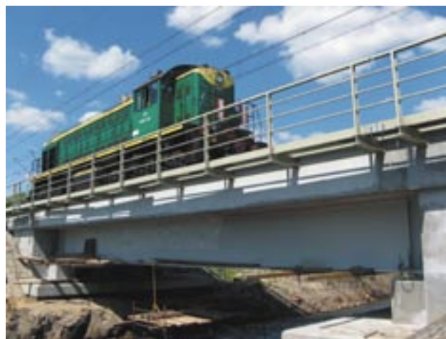
ZDJ. 2. PRZEJAZD LOKOMOTYWY PODCZAS BADANIA DYNAMICZNEGO
