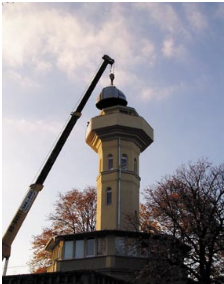
MONTAŻ KOPUŁY NA SZCZYPICE WIEŻY BRANIBORSKIEJ
