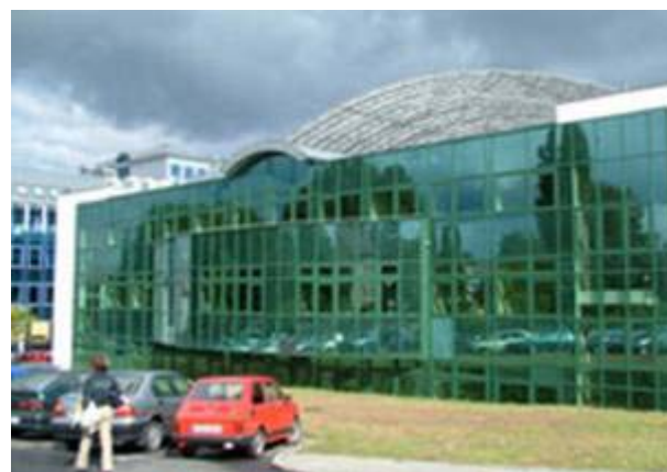
ZMODERNIZOWANA HALA LABORATORYJNA WYDZIAŁU MECHANICZNEGO
