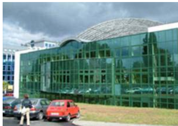
ZMODERNIZOWANA HALA LABORATORYJNA WYDZIAŁU MECHANICZNEGO
