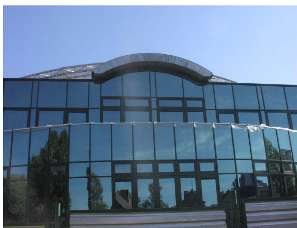
JUŻ WKRÓTCE ZOSTANIE ODDANA DO UŻYTKU MODERNIZOWANA HALA LABORATORYJNA WYDZIAŁU MECHANICZNEGO
