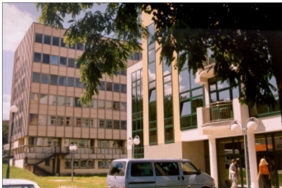
FRAGMENT CAMPUSU A PRZY ULICY PODGÓRNEJ NA PIERWSZYM PLANIE SIEDZIBA WYDZIAŁU MECHANICZNEGO, W GŁĘBI MIĘDZYWYDZIAŁOWY BUDYNEK DYDAKTYCZNY. WKRÓTCE OBOK STANIE BUDYNEK WYDZIAŁU NAUK ŚCISŁYCH.
