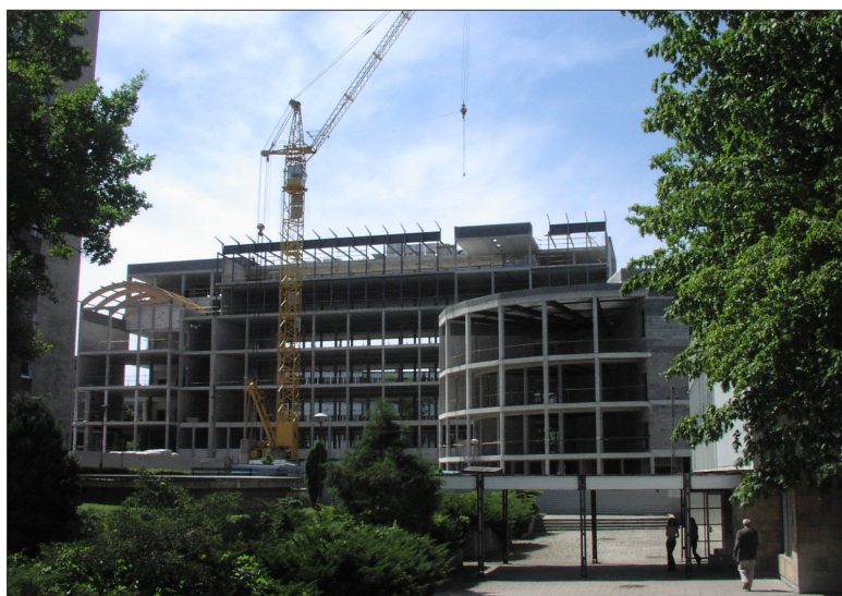
CORAZ BARDZIEJ ZAAWANSOWANA JEST BUDOWA SIEDZIBY INSTYTUTU BUDOWNICTWA
