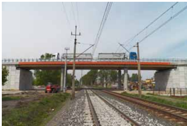
WIDOK WIADUKTU PODCZAS BADANIA POD PRÓBNYM OBCIĄŻENIEM (FOT. Z WYDZIAŁU)
