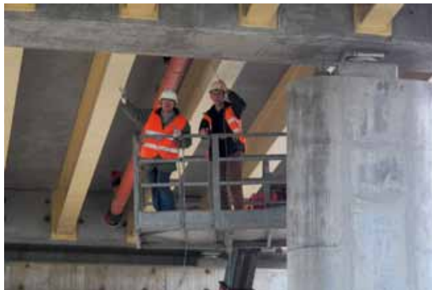
MONTAŻ APARATURY POMIAROWEJ POD BADAANYM WIADUKTEM (FOT. Z WYDZIAŁU)
