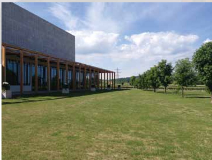
_OBIEKTY ECMKP (FOT. BARBARA LITERSKA)
