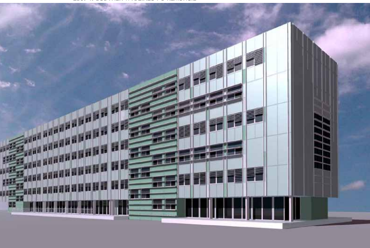
ZDJ. 4. BUDYNEK WYDZIAŁU PO REMONCIE
