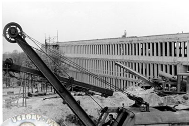
ZDJ.1. WSINŻ W BUDOWIE - POCZĄTKI ISTNIENIA WYDZIAŁU
