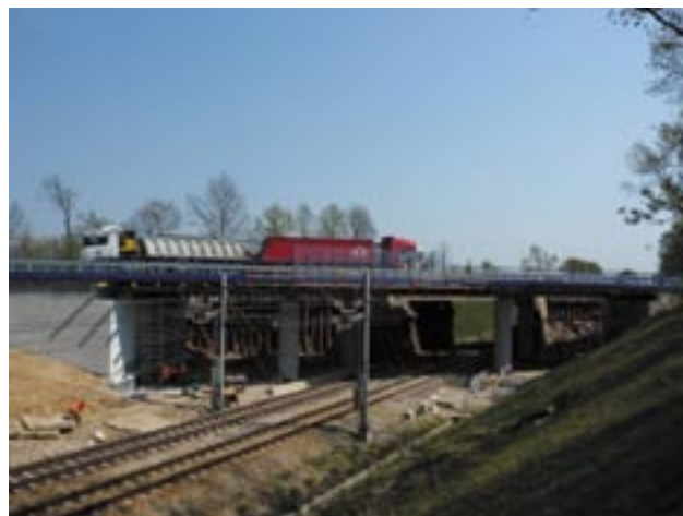
FOT. 1. BADANY WIADUKT POD PRÓBNYM OBCIĄŻENIEM
