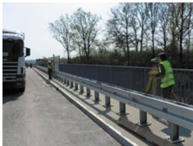
FOT. 2. POMIARY SPRAWDZAJĄCE Z UŻYCIEM NOWOCZESNEGO SPRZĘTU GEODEZYJNEGO
