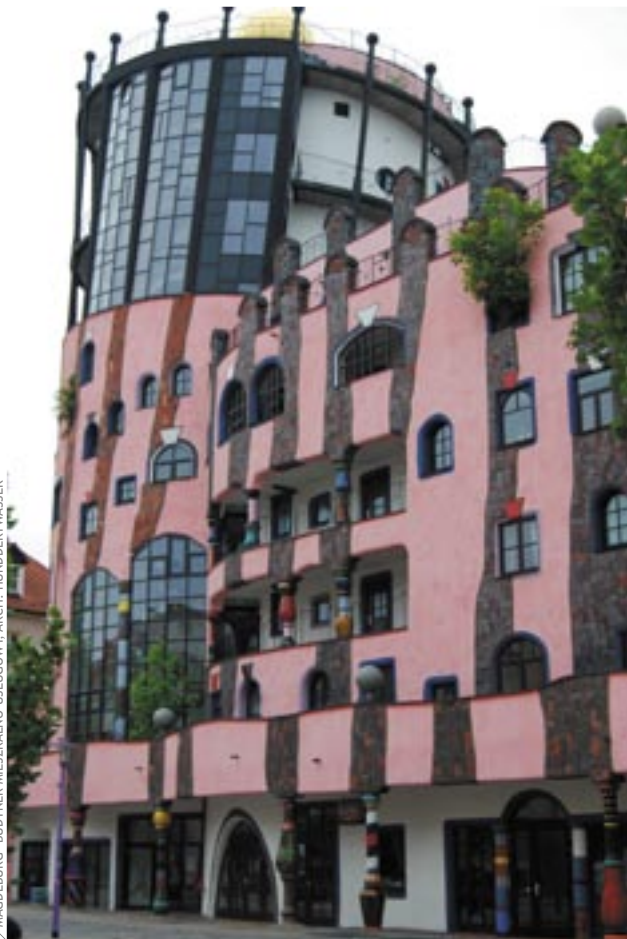
> MAGDEBURG - BUDYNEK MIESZKALNO-USŁUGOWY, ARCH. HUNDERTWASSER
