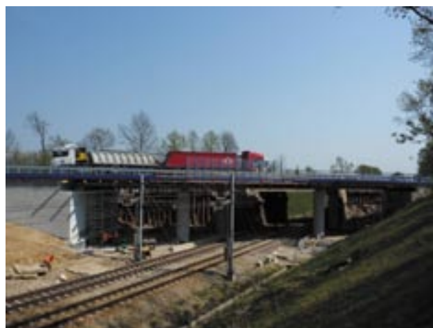
FOT. 1. BADANY WIADUKT POD PRÓBNYM OBciążENIEM
