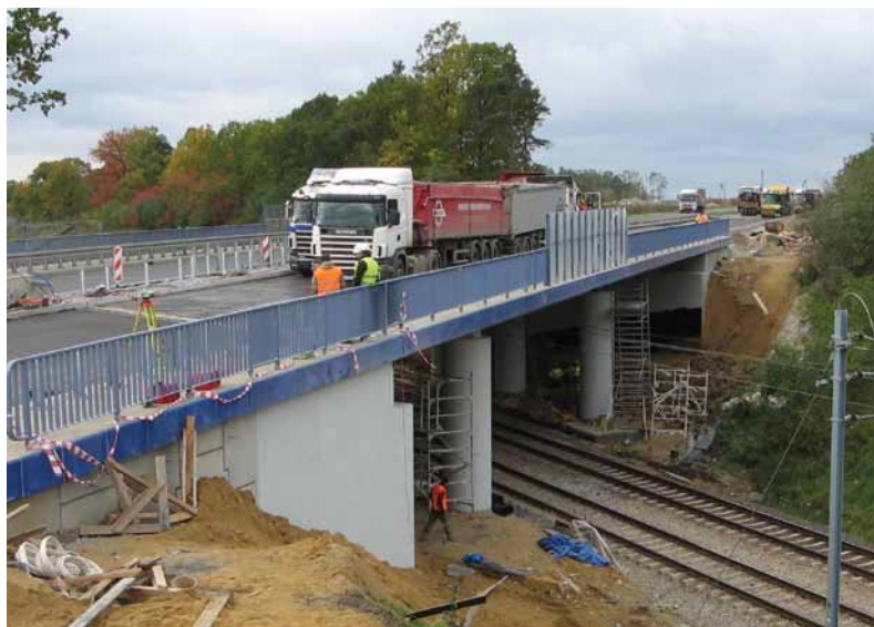
> BADANY WIADUKT POD PRÓBNYM OBCIĄŻENIEM - PRZEŚŁO ŚRODKOWE
