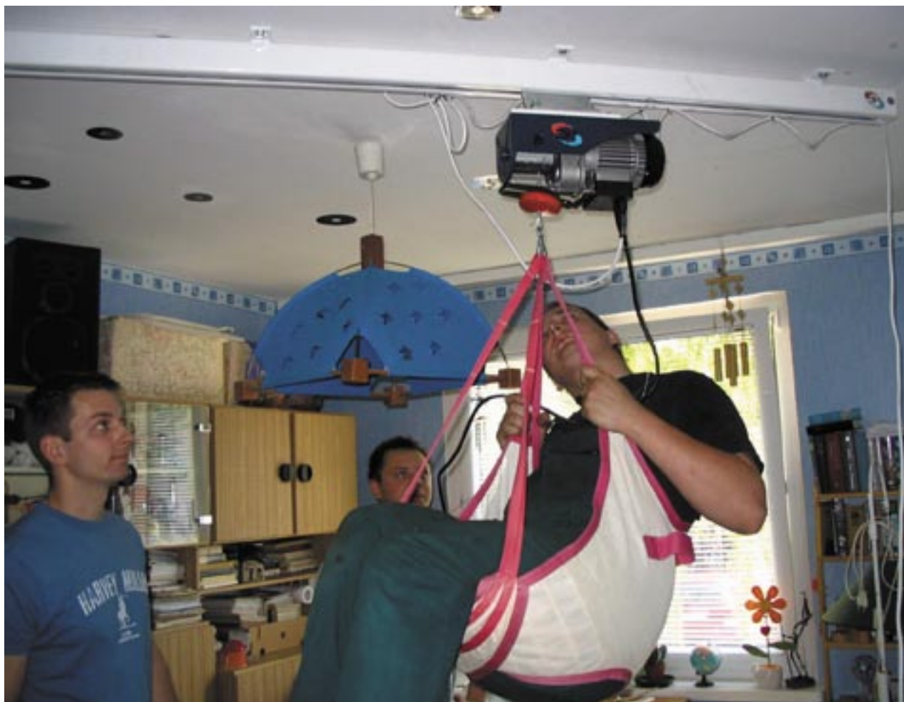
> STUDENCI KN 3P PODCZAS MONTAŻU PIERWSZEJ WERSJI PODNOŚNIKA. SZCZEGÓLNE PODZIĘKOWANIA CHCIAŁBYM ZŁOŻYĆ JARKOWI KORNECKIEMU KTÓRY PODAJE SIĘ WYKONANIA ZAPROJEKTOWANEGO URZĄDZENIA.
