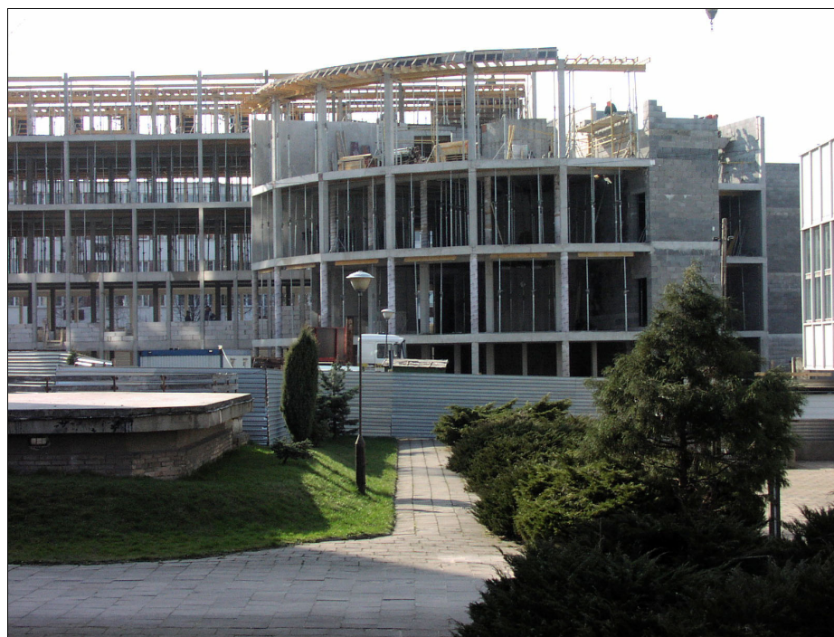
WIOSNĄ NABRAŁY TEMPĄ PRACE PRZY BUDOWIE INSTYTUTU BUDOWNICTWA
