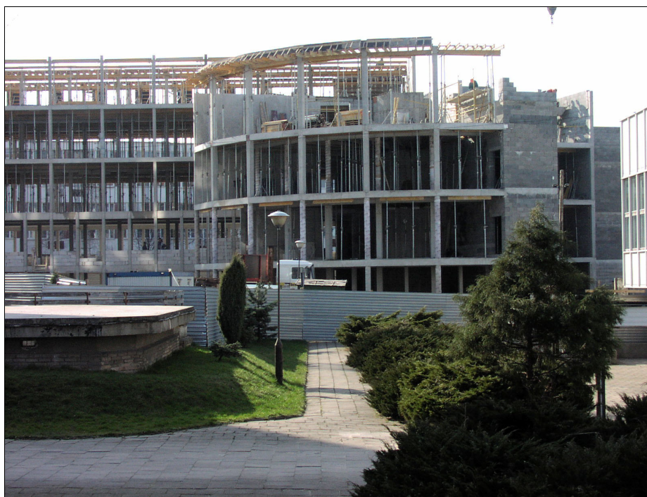
WIOSNĄ NABRAŁY TEMPĘ PRACE PRZY BUDOWIE INSTYTUTU BUDOWNICTWA
