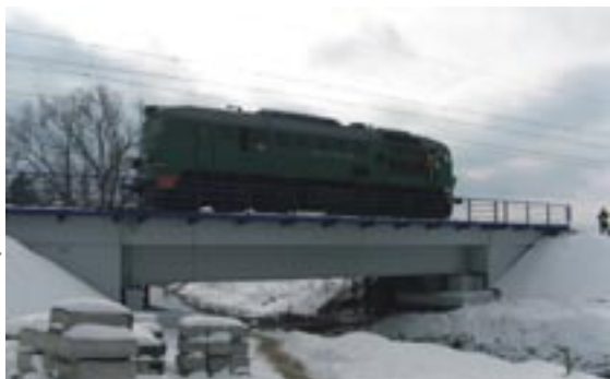
USTAWIENIE LOKOMOTYWY W TRAKCIE OBCIĄŻENIA PRÓBNEGO
