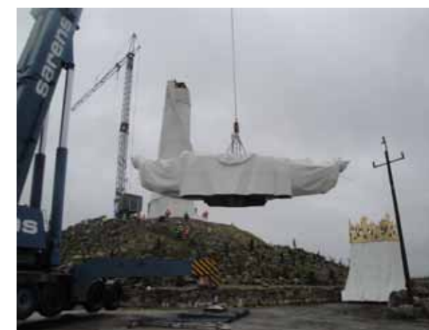
FOT. 4. MONTAŻ GÓRNEGO FRAGMENTU FIGURY
