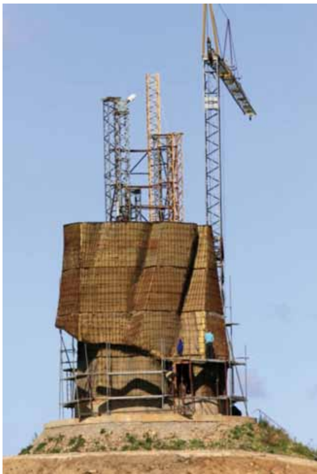
FOT. 3. TRÓJWARSTWOWA POWŁOKA PŁASZCZA FIGURY
