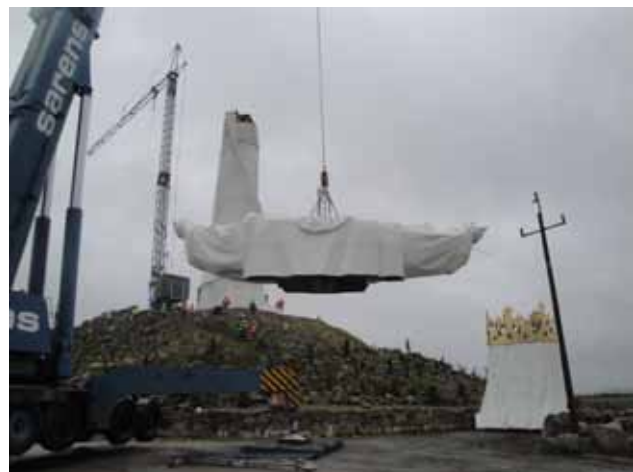
FOT. 4. MONTAŻ GÓRNEGO FRAGMENTU FIGURY
