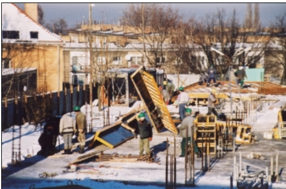
TRWAJĄ PRACE BUDOWLANO-MONTAŻOWE W PRZYSZŁYM INSTYTUCIE BUDOWNICTWA
